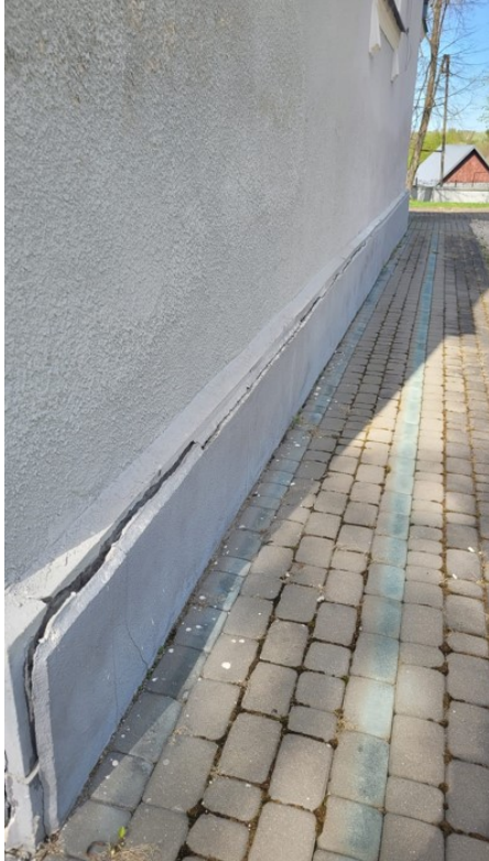
Fot.4. Stan techniczny cokołu na elewacji wschodniej, źródło: fotografie własne
