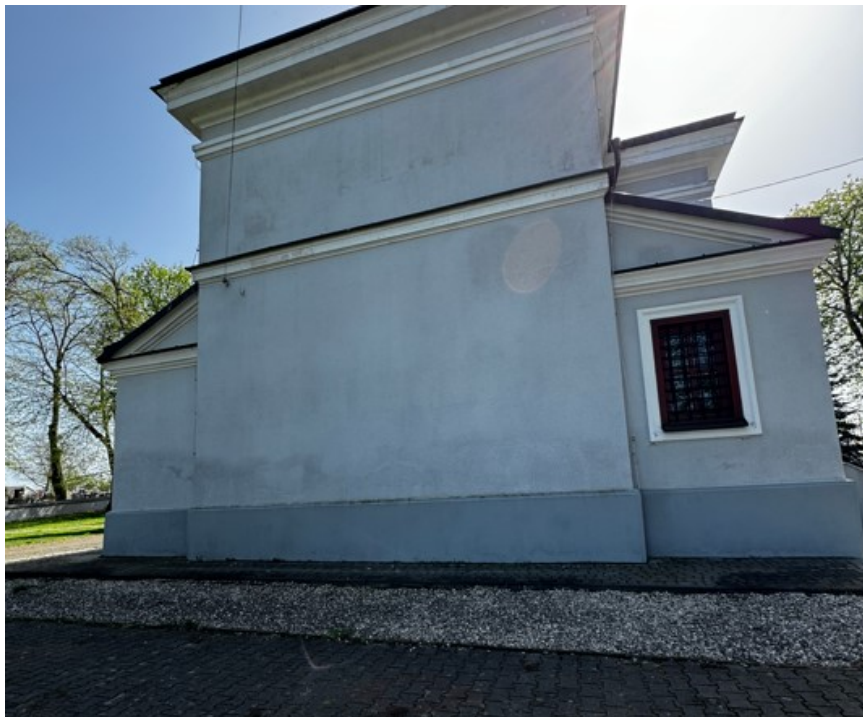
Fot.6. Zniszczenie wtórnych warstw tynku na elewacji północnej, źródło: fotografie własne
